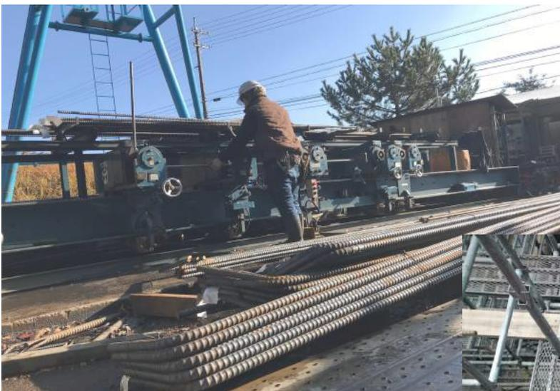
まずは実際の組み立てに使う長さ、形状に鉄筋を加工
